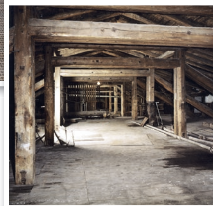
Dachboden-Lagerraum mit Holzkonstruktion im Originalzustand.
