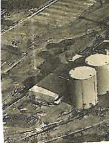
Sie sah die Baustelle nach Ende Oktober 1968 an.
